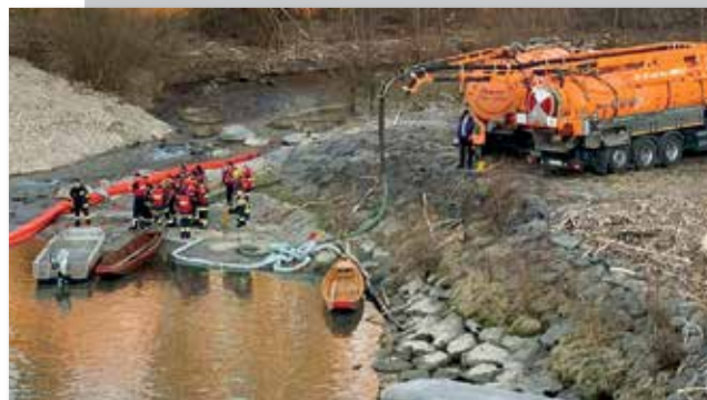
Ölabsaugung unterhalb des Kraftwerks
